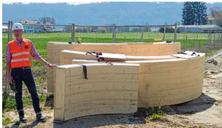
Auch geschwungene Elemente sind in dieser Bauweise kein Problem, erklärt Alexander Kopp vom Bauamt. Fotos: Durlacher
