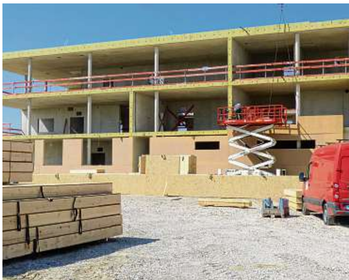
Stück für Stück wächst die Fassade an der neuen Eichendorff-Realschule empor.
