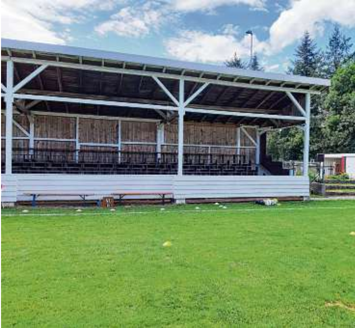
Der untere Teil der Tribüne des SC GoBi wurde rechtzeitig fertiggestellt.
