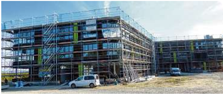
Die Fassade nimmt immer mehr Gestalt an.
