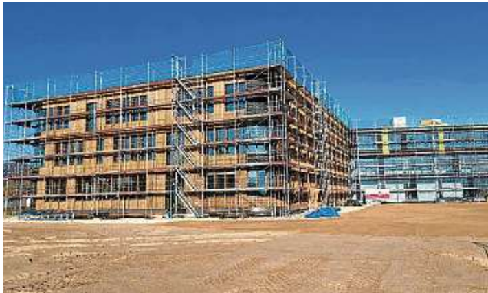
Die Holzfassade mit den Kanthölzern aus Lärchenholz ist bereits zur Hälfte fertiggestellt.
