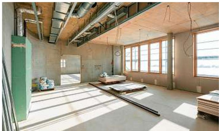
Die Decken- und Wandverkleidungen entstehen. Dahinter verschwinden die ganzen Installationen.
