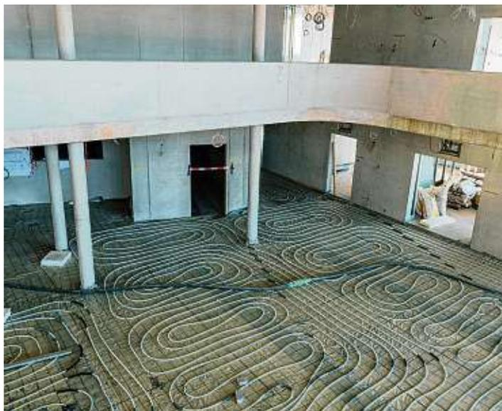
Im Bereich der zweigeschossigen Mensa werden kilometerweise Heizleitungen verlegt, die später niemand mehr sieht, aber für wohlige Wärme sorgen.
