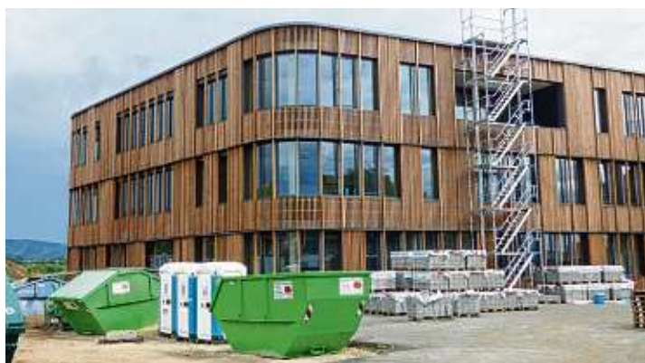
Die Fassade der neuen Schule ist bis auf wenige Stellen fertig.
