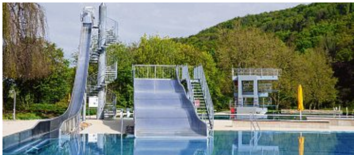
Becken und Geräte werden für die Saison vorbereitet.
