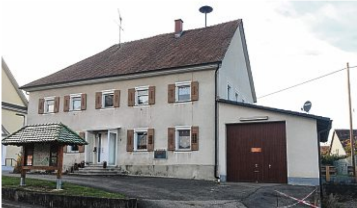
Weder zeitgemäß noch vorschriftsmäßig: das alte Feuerwehrhaus.
