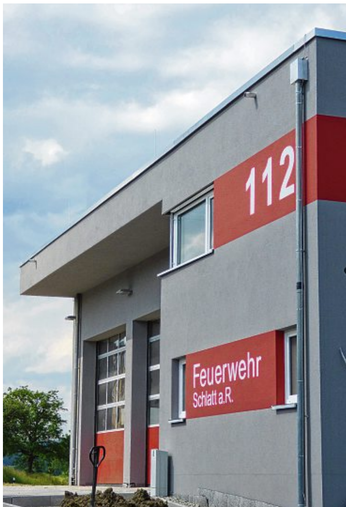
Stolz steht das neue Feuerwehrhaus am Schlatter Ortseingang.
